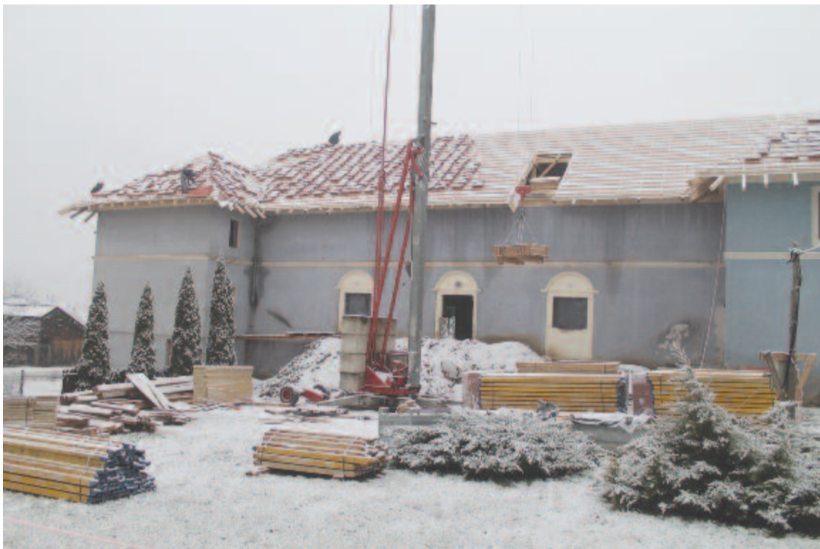
A szakadó hóesésben is dolgoztak a tetőn
