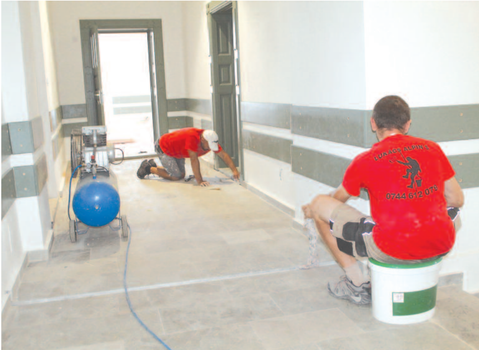
Utolsó simítások a Református Kollégium régi épületszárnyán
