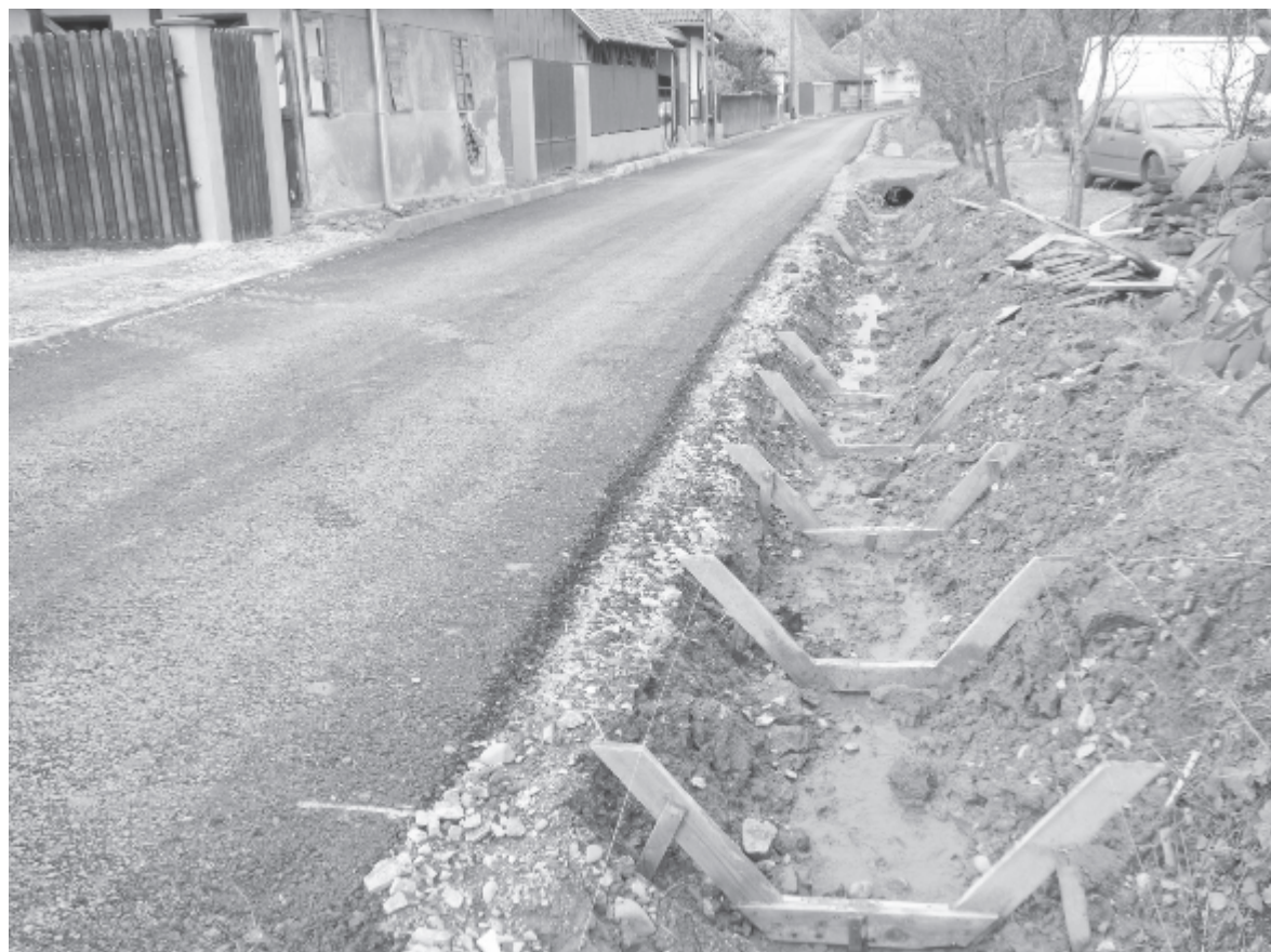
Az aszfaltozás mellett ki kell betonozni a sáncokat, átereszeket, kapubejárókat kell építeni
