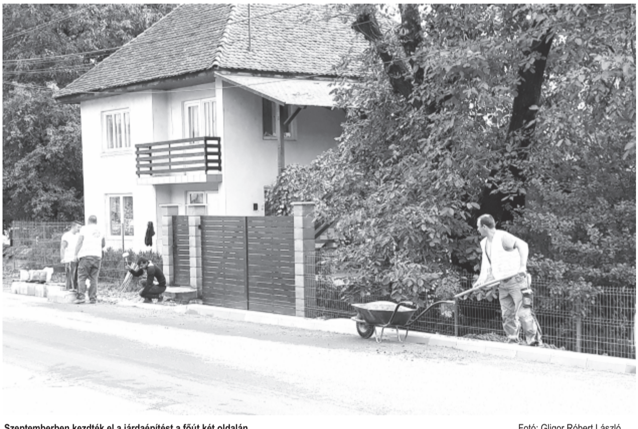
Szeptemberben kezdték el a járdaépítést a főút két oldalán
