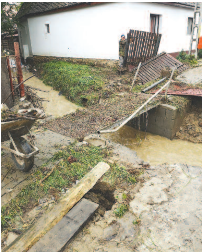
Nyárádremetén is súlyos károkat okozott az áradás
