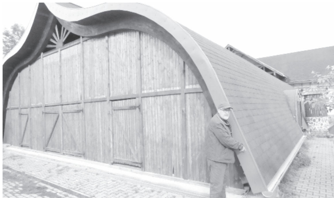
Teljesen megújult a nézőtér tetőzete és padlózata, elvezették a csapadékvizet
