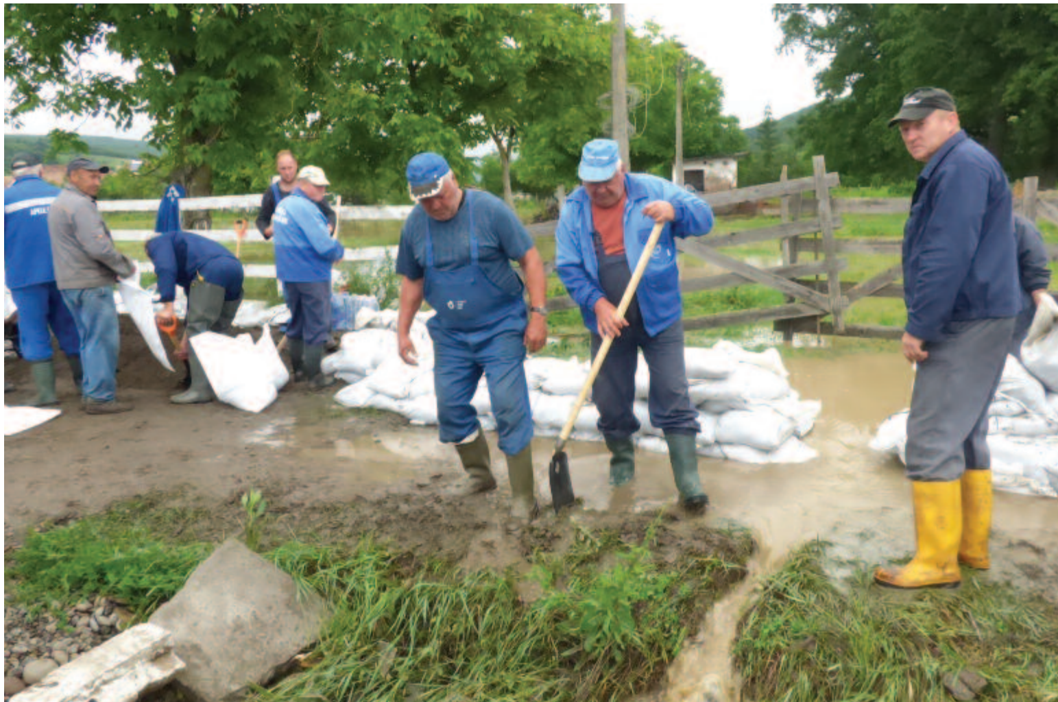
Nyárádszeredában pénteken a helyi katasztrófavédelem és a vízügyi hatóság munkacsoportjai védvonalat építettek
