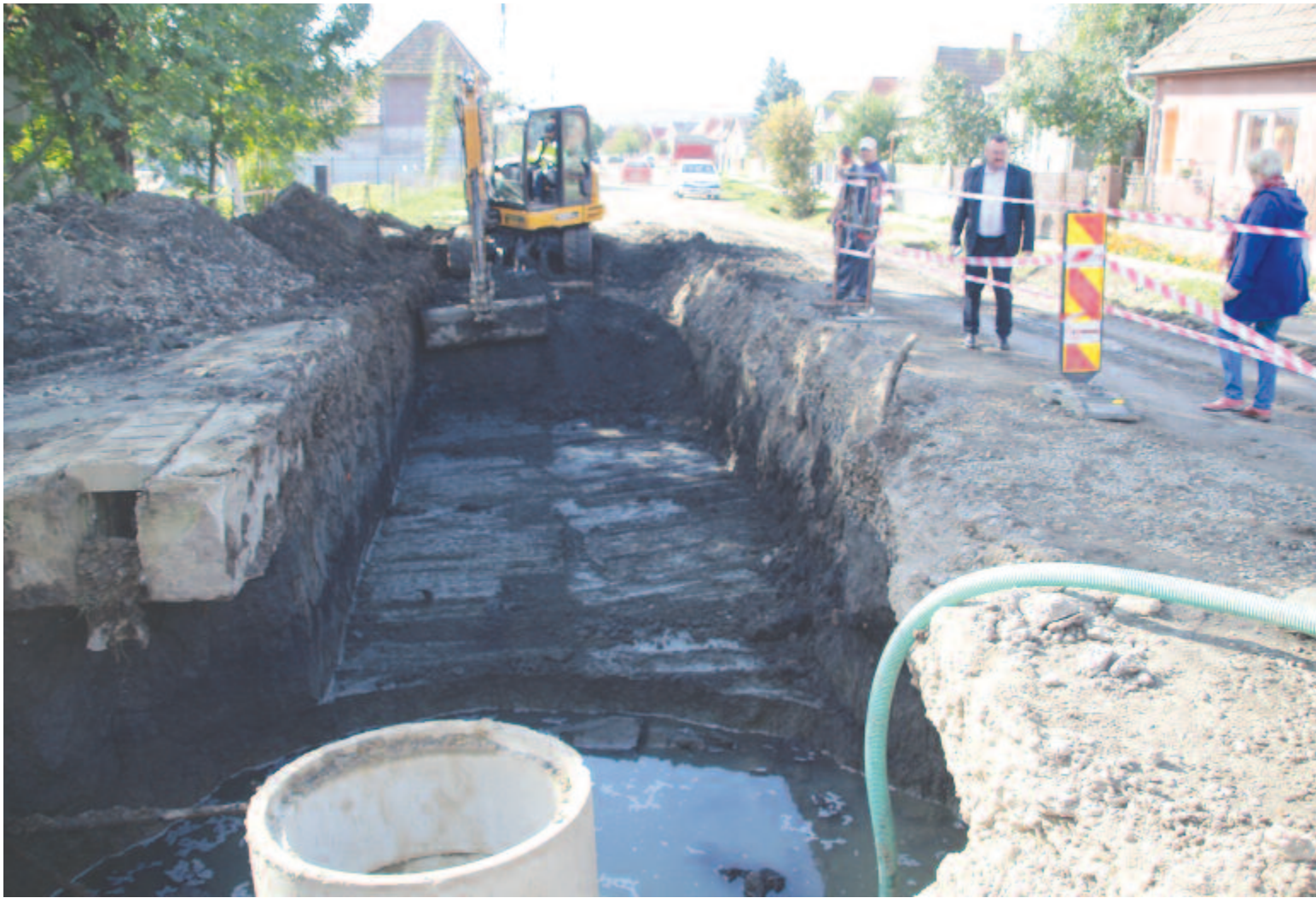
A csibaszentmiklósi szivattyúállomás munkálatai (Vendégoldalunk a 6. oldalon)
