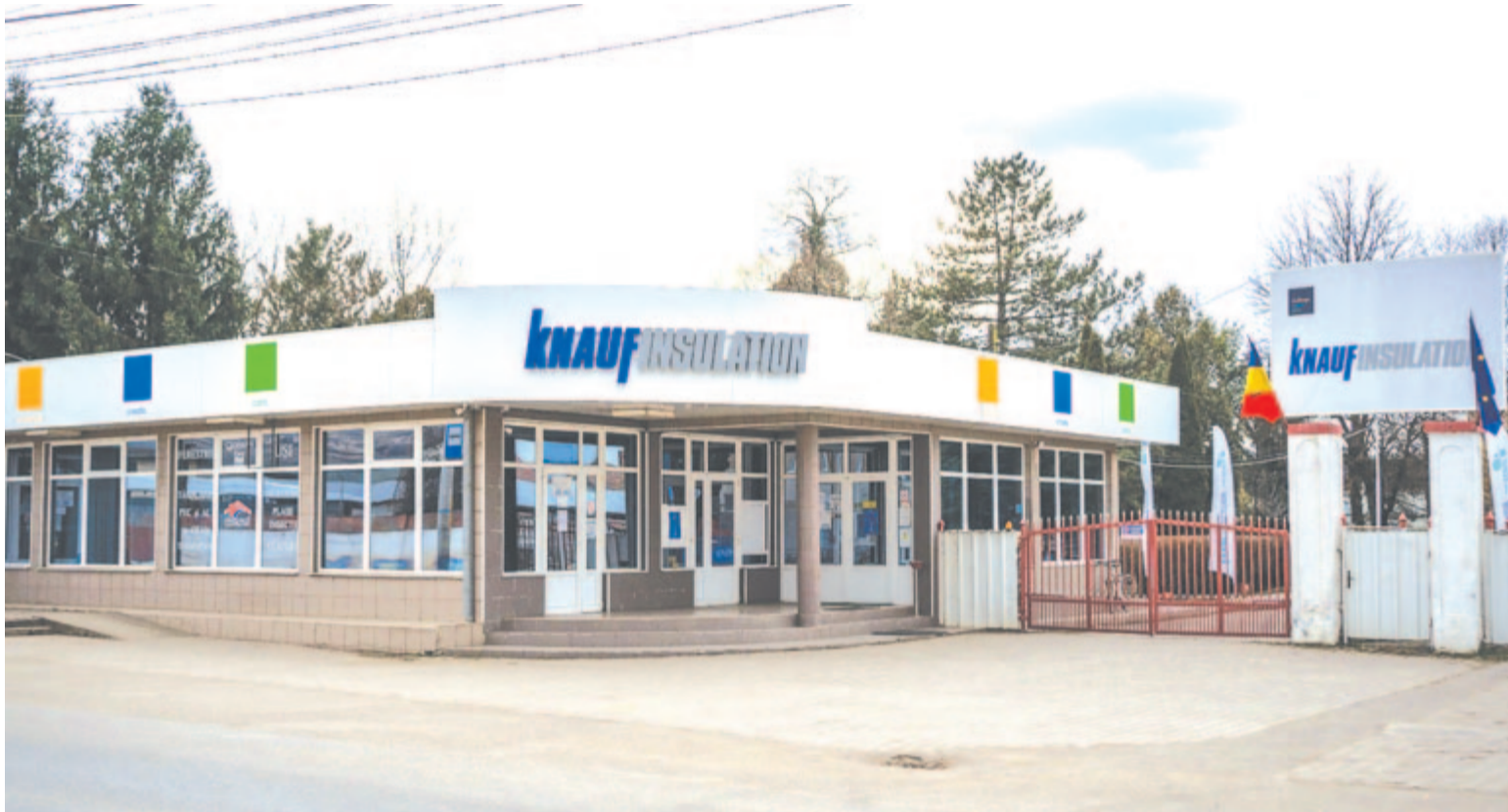
Knauf Insulation, Dicső
