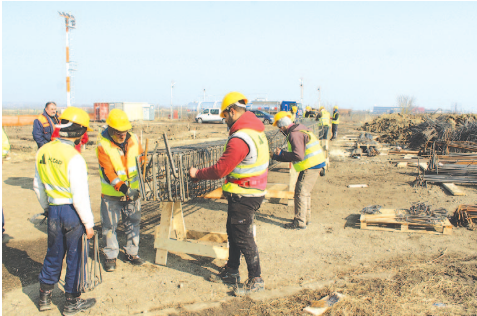
Építik az új tűzoltóállomást
