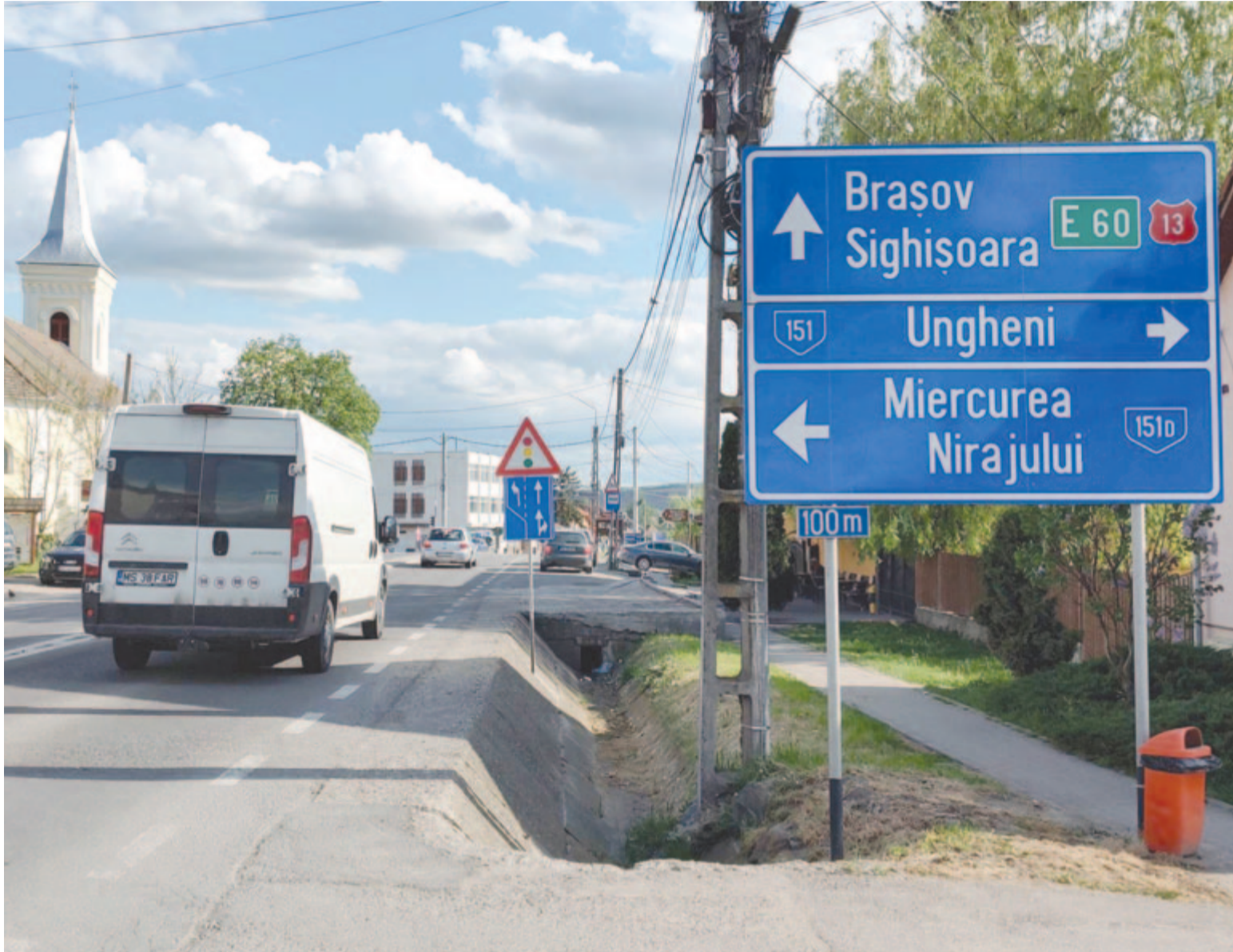
A jelenlegi útkeresztvezetés alkalmatlan, balesetveszélyes
