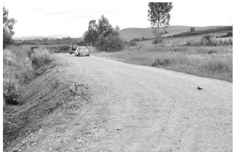
A megrongált útszakaszt visszatöltötték a víz által elmosott anyaggal, de kérdés, hogy az így biztonságos-e. Főleg, hogy figyelmeztető táblákat sem helyeztek ki
