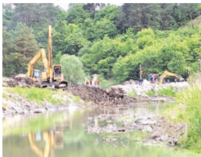
Csöveken próbálják elvezetni a patak vizét, hogy megakadályozzák a beszivárgást Fotó: Karácsonyi Zsigmond
