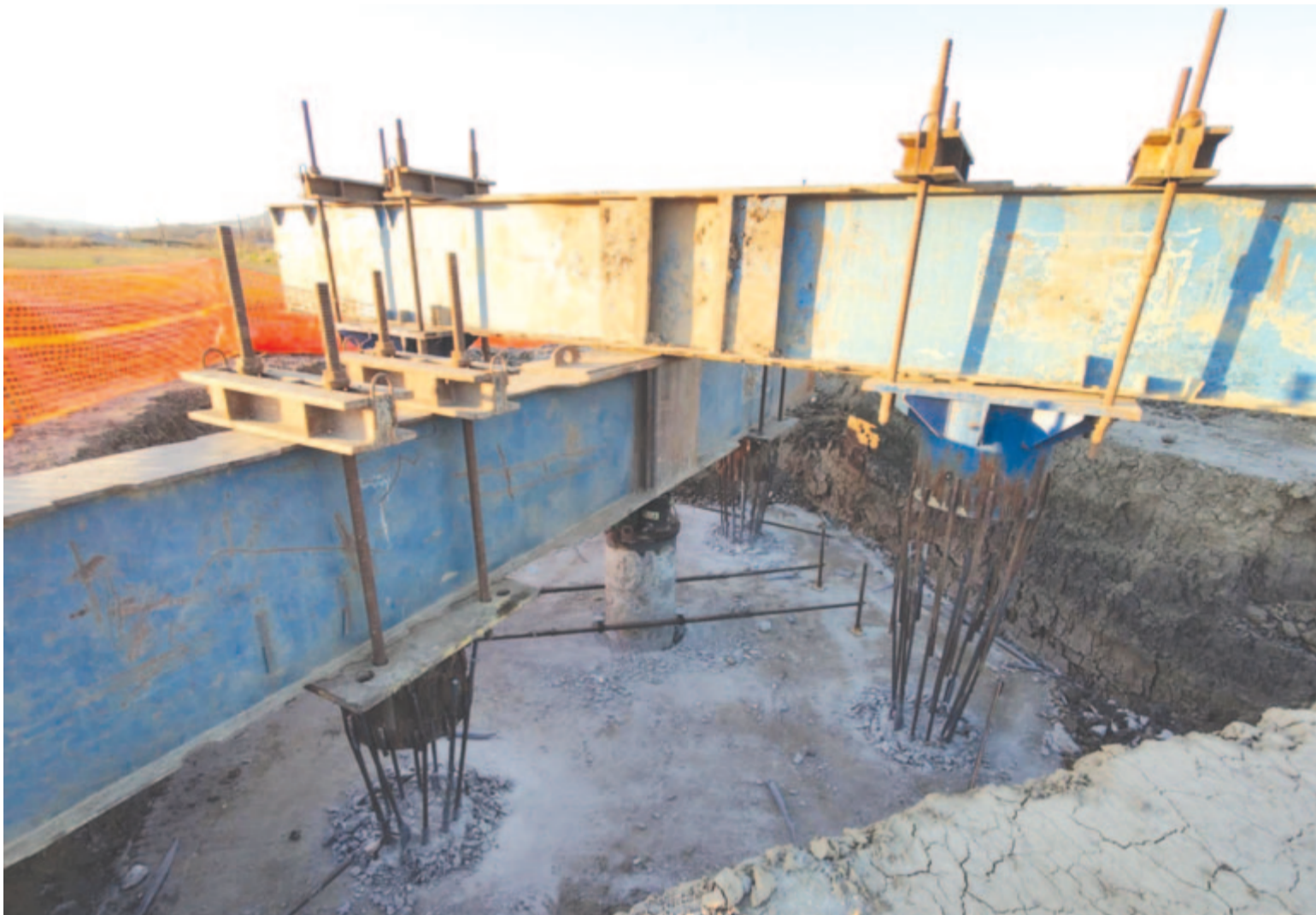
Az utolsó nyomvonalakat is kijelölték, máshol megkezdtek az alapozás előkészítését
