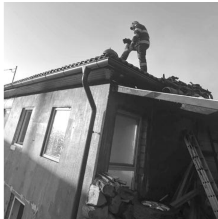
A lakás teljes tetőszerkezete megsemmisült a reggel keletkezett tűzben. Fotó: NYÖTE
