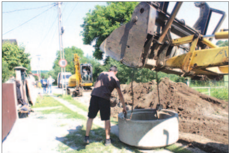
Épül a szennyvízvezeték a mellékutcákban
