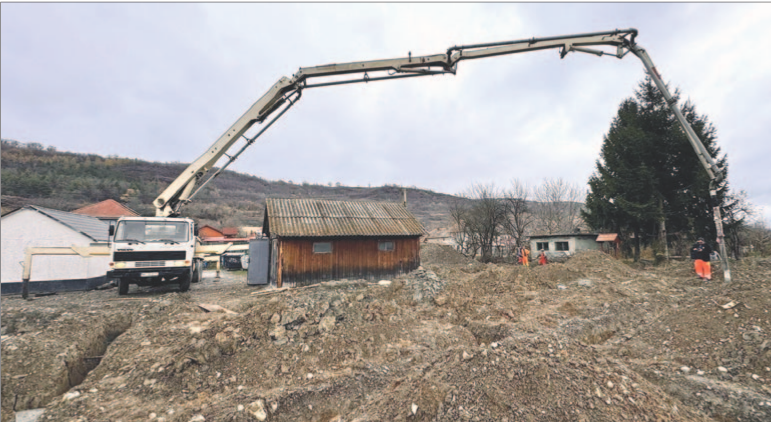
Múlt héten kezdték az alapozási munkálatokat a leendő idősfoglalkoztató központ épületénél
